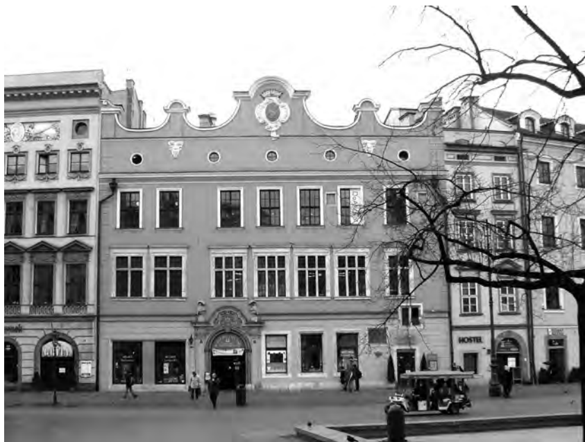
Il. 11. Kamienica Hetmańska – Kraków, Rynek Główny 17. Przykład daleko posuniętej kreacji konserwatorskiej z lat osiemdziesiątych XX w. Fot. Autor
