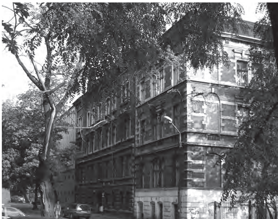
Ryc. 4, 5. Przykładowe kamienice zabytkowe przeznaczone do wyburzenia w związku z budową trasy. (fot. M. Żmudzińska-Nowak)
